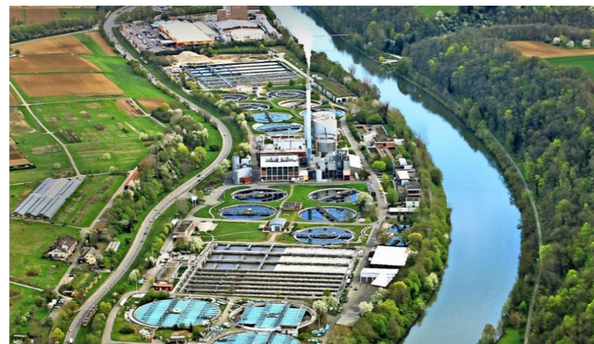
Grösstes Solarfaltdach in DE – 2745 kWp KW Stuttgart, 2025
