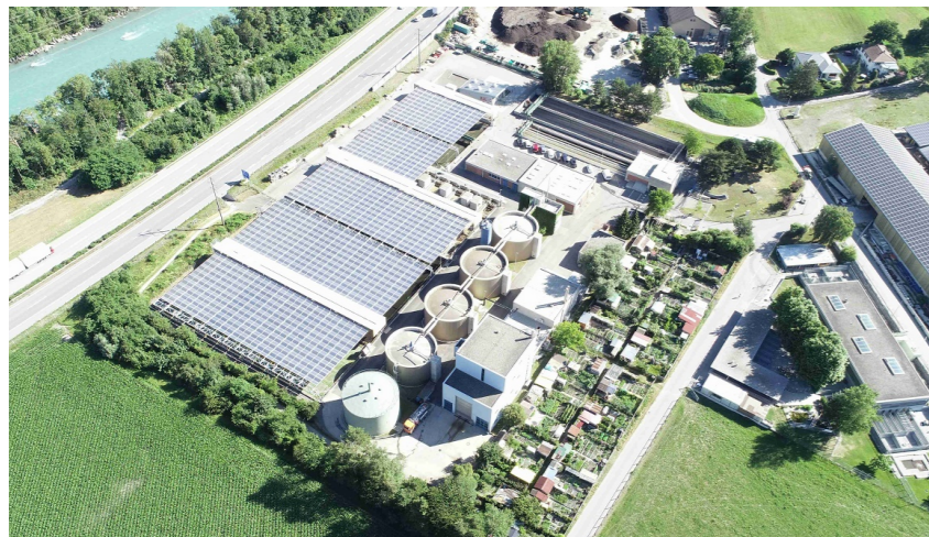
Pilotprojekt ARA Chur – 643 kWp 2017/2018
