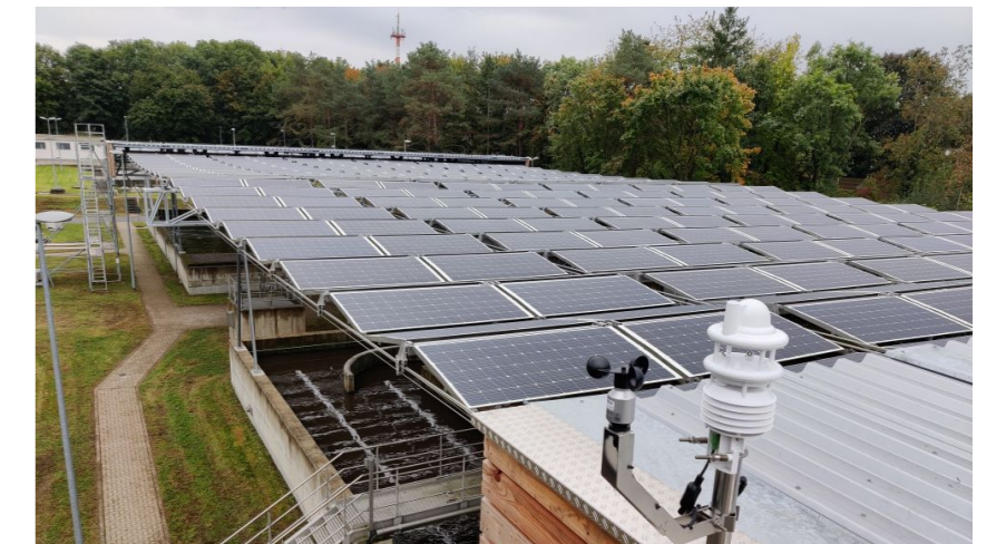
Das erste Solarfaltdach in DE – 243 kWp KA Neuwied, Gewinner Deutscher Solarpreis 2023
