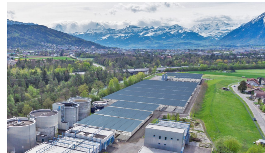
Grösstes Solarfaltdach in CH – 3600 kWp ARA Thunersee, 2025
